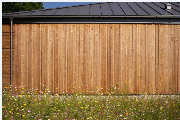
Frisch montierte Fassade
