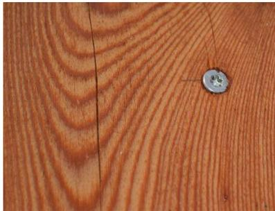
Bei zu starkem eindrehen der Schraube, oder nicht sachgerechter Verschraubung gemäß der Verlegeanleitung, kann das Holz am Schraubloch einreißen.
