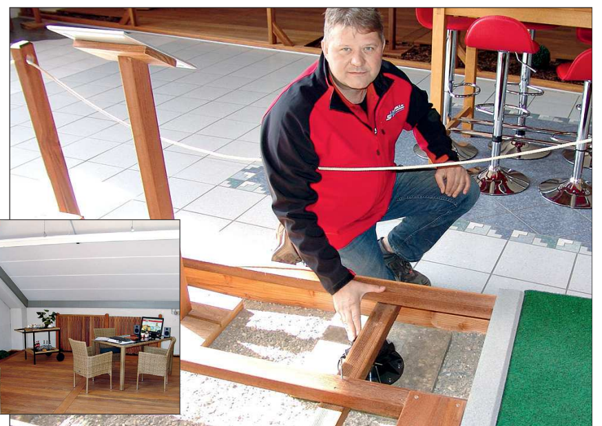
Etwa 3 000 m 2 Terrassendielen pro Jahr verlegt Inhaber und Geschäftsführer Knut Severin mit seiner eigenen Mannschaft. Dann versucht er auch, die Kunden von den Vorteilen der Kreuzlattung zu überzeugen, die er im Ausstellungsbereich am Firmensitz in Zwiefalten anschaulich aufgebaut hat. Dort führt er auch die Beratungsgespräche durch (kleines Bild). Alle Kalkulationen laufen dabei auf dem Programm, auf das auch alle Kunden auf der Homepage Zugriff haben. Fotos: Fischer
